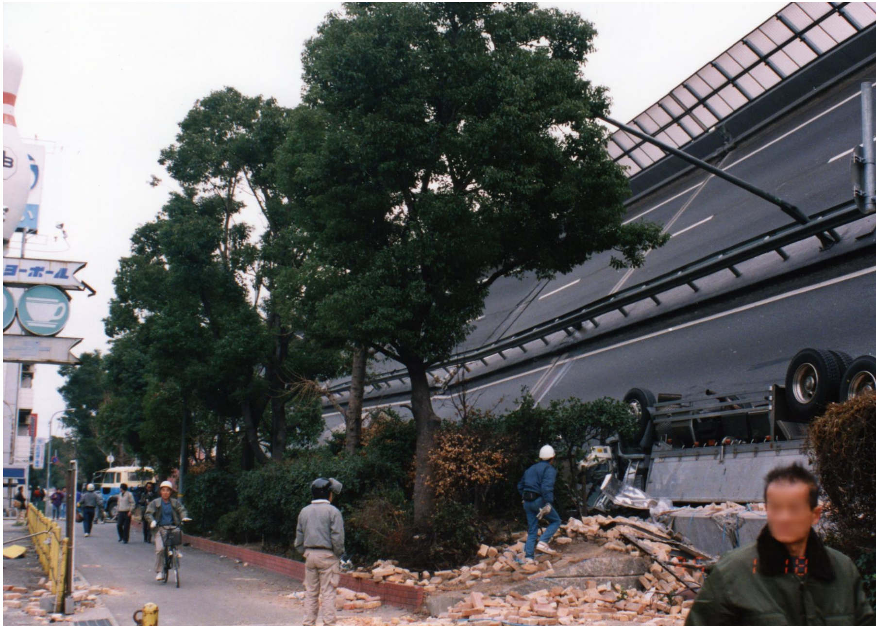
神戸市東灘区の阪 神高速倒壊現場で 1995年1月18日 写真提供・神戸市
