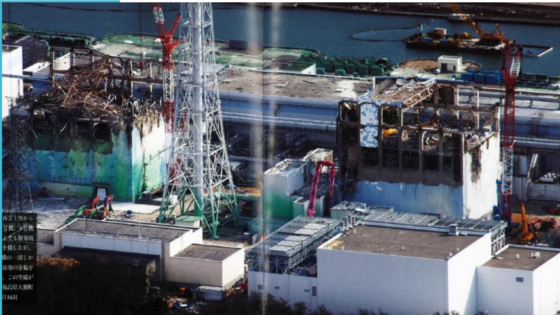
水素爆発によって屋根や壁が吹き飛んだ3号機、4号機の原子炉建屋 (東電株主代表訴訟甲753・212頁、213頁)
