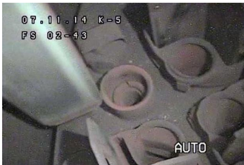
5号炉の核燃料が支持金具から外れた様子 東京電力
